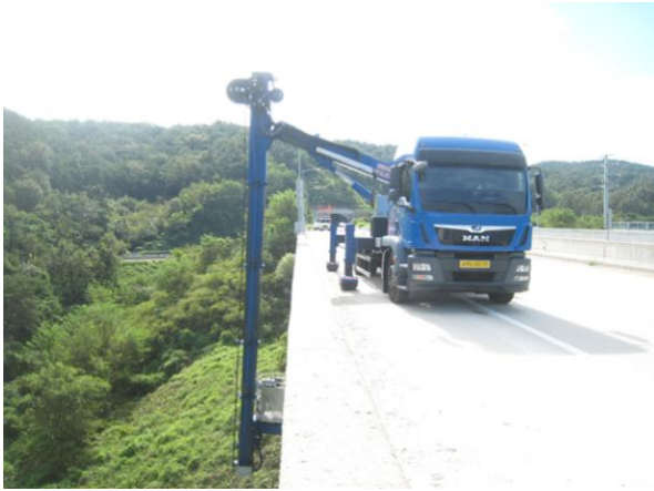
굴절점검차를 이용한 근접조사
