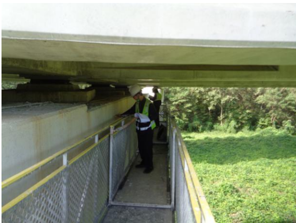
굴절점검차를 이용한 근접조사
