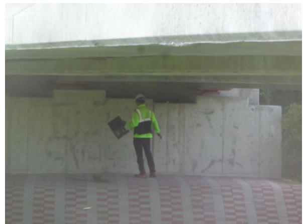
도보를 이용한 근접조사
